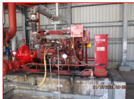
ภาพที่ 2.2-8 เครื่องสูบน้ำแบบเครื่องยนตดีเซล
