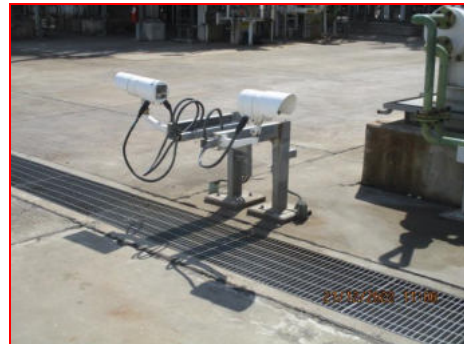
ภาพที่ 2.2-23 ระบบตรวจวัดการรั่วไหลของแก๊ส (Gas Detector)
