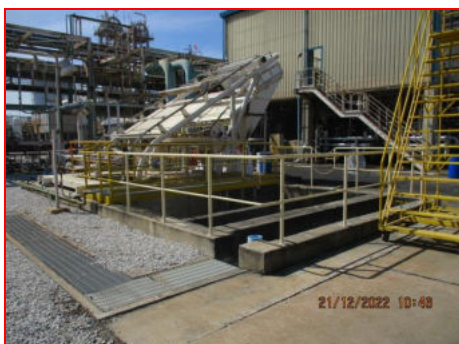
ภาพที่ 2.2-7 บ่อตกโพลิเมอร์และถุง Jumbo bag สำหรับรวบรวม โพลิเมอร์เพื่อรอส่งกำจัด
