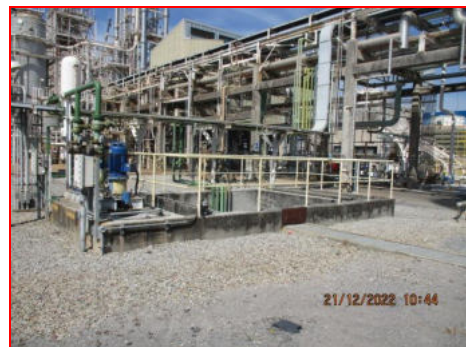
ภาพที่ 2.2-4 บ่อพักน้ำทิ้ง (Purification Basin)
