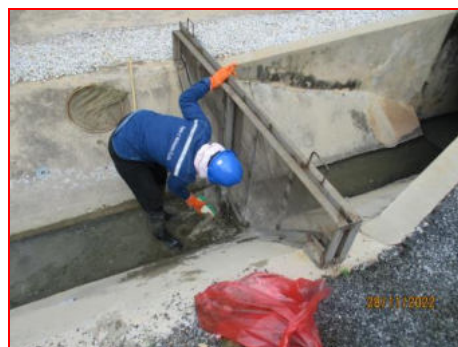
ภาพที่ 2.2-10 การทำความสะอาดรางระบายน้ำฝน
