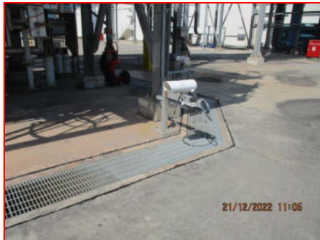
ภาพที่ 2.2-23 ระบบตรวจวัดการรั่วไหลของแก๊ส (Gas Detector)
