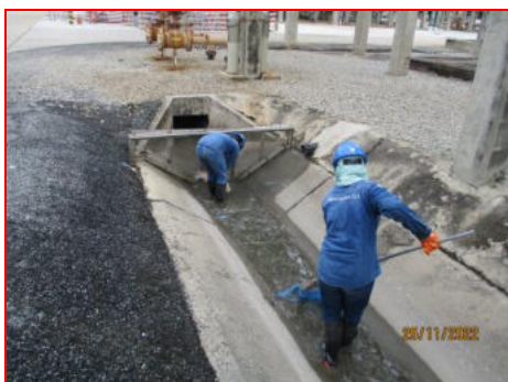
ภาพที่ 2.2-10 การทำความสะอาดรางระบายน้ำฝน
