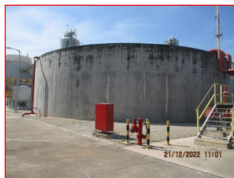
ภาพที่ 2.2-34 ถังเก็บน้ำสำรองดับเพลิง
