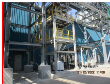
ภาพที่ 2.2-30 ระบบรวบรวมฝุ่นจากบริเวณที่มีการฟุ้งกระจาย ของสารเคมีในอาคาร Pellet 3
